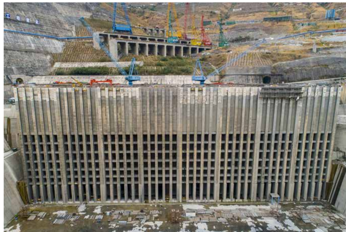
左岸进水塔施工形象
