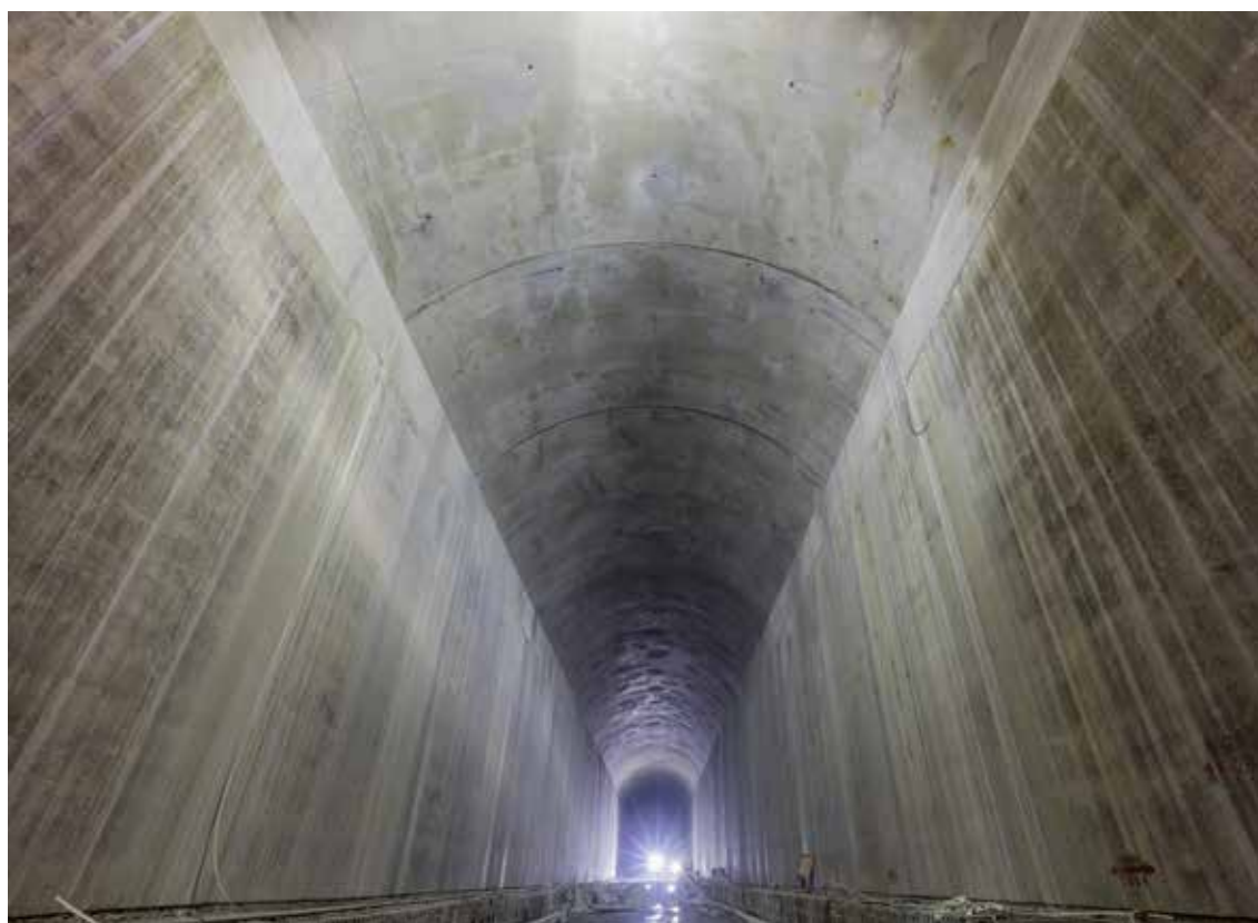
2019 年左岸 1 号泄洪洞龙落尾边顶拱衬砌备仓形象
