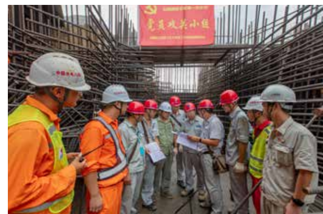
党员攻关小组检查 19 坝段泄洪深孔备仓
