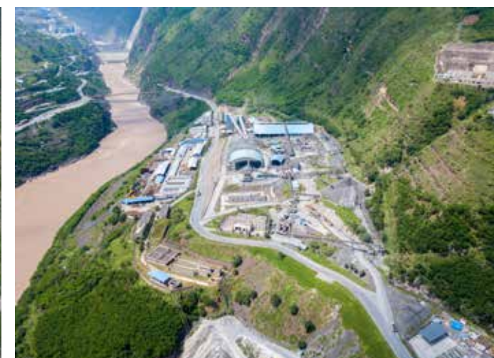
三滩砂石混凝土系统
