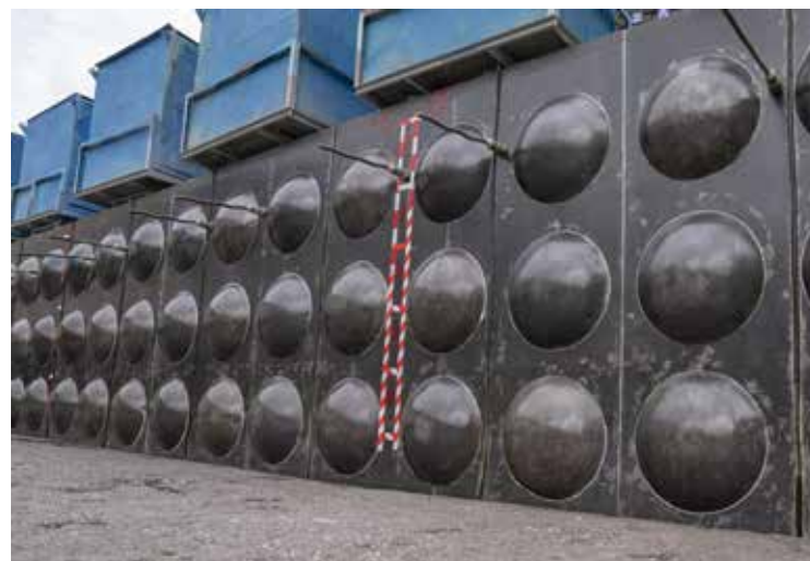
大坝导流深孔钢衬备仓安装施工形象
