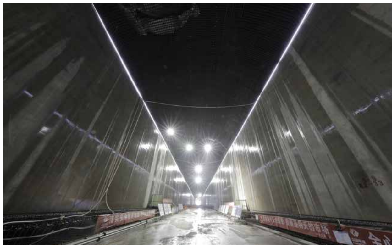
2017 年左岸 2 号泄洪洞边顶拱衬砌形象
