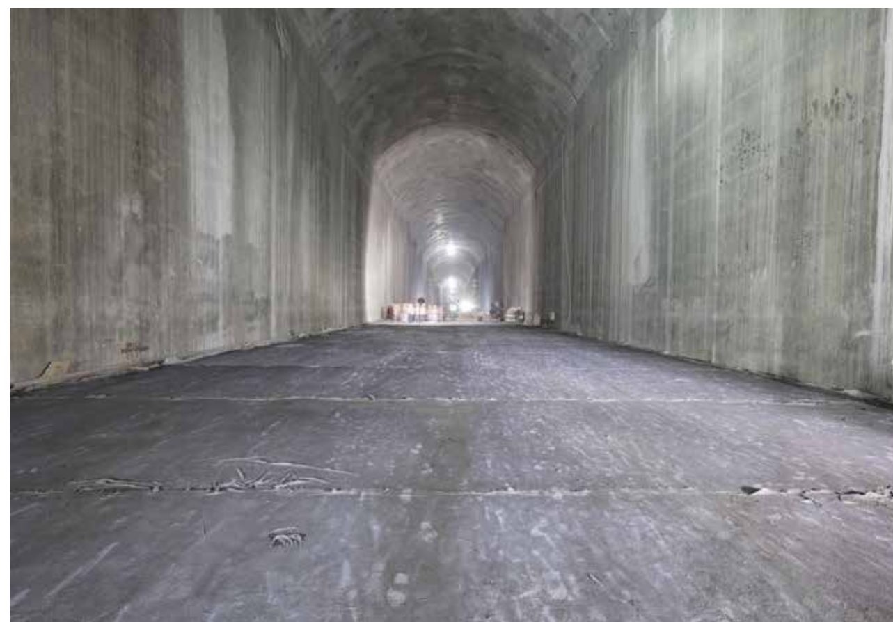
左岸 3 号泄洪洞底板边顶施工形象
