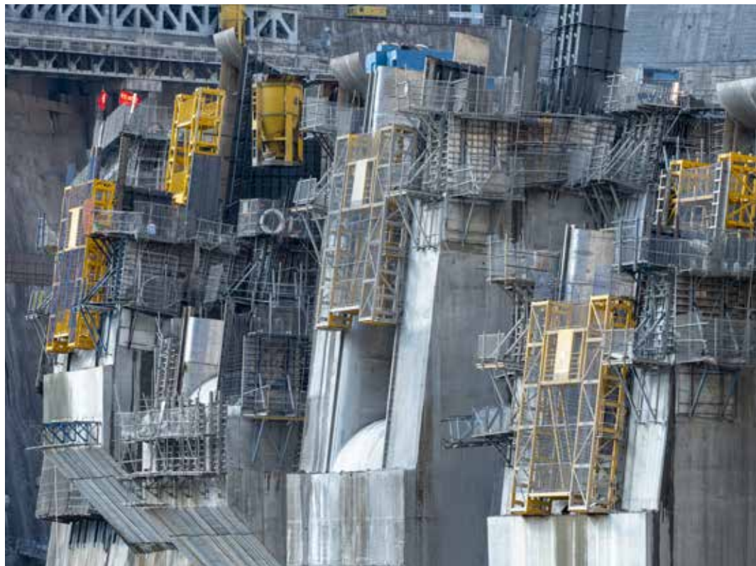
大坝深孔备仓浇筑施工形象
