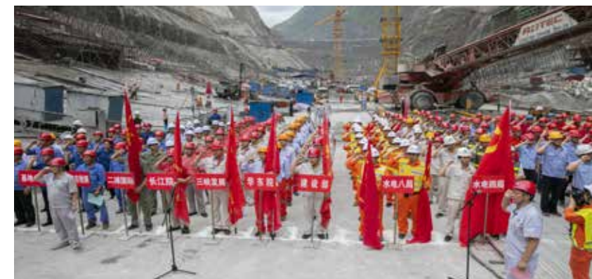
施工区灌浆者党员参加廉洁诚信承诺宣誓主题党日活动
