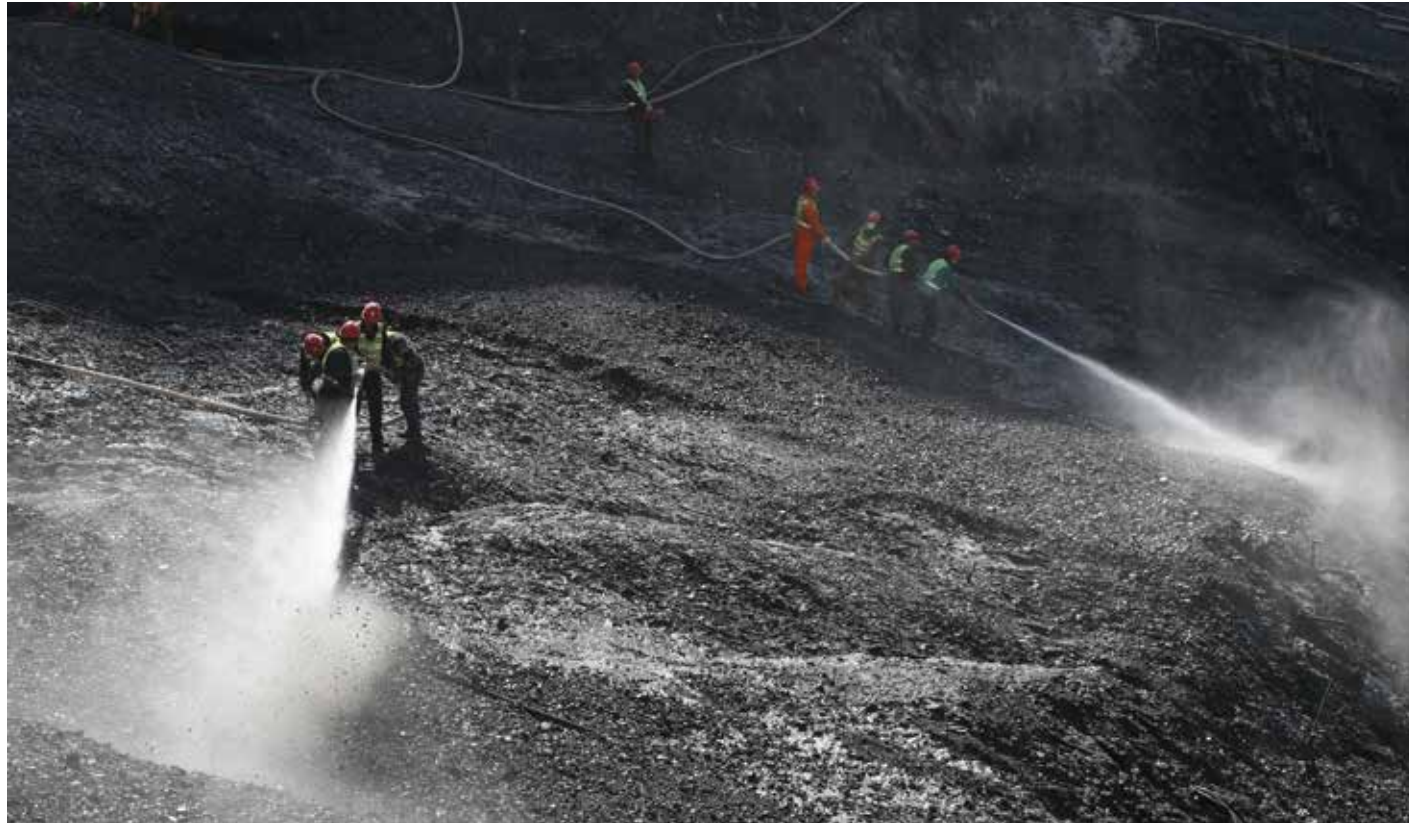
大坝基坑清理
