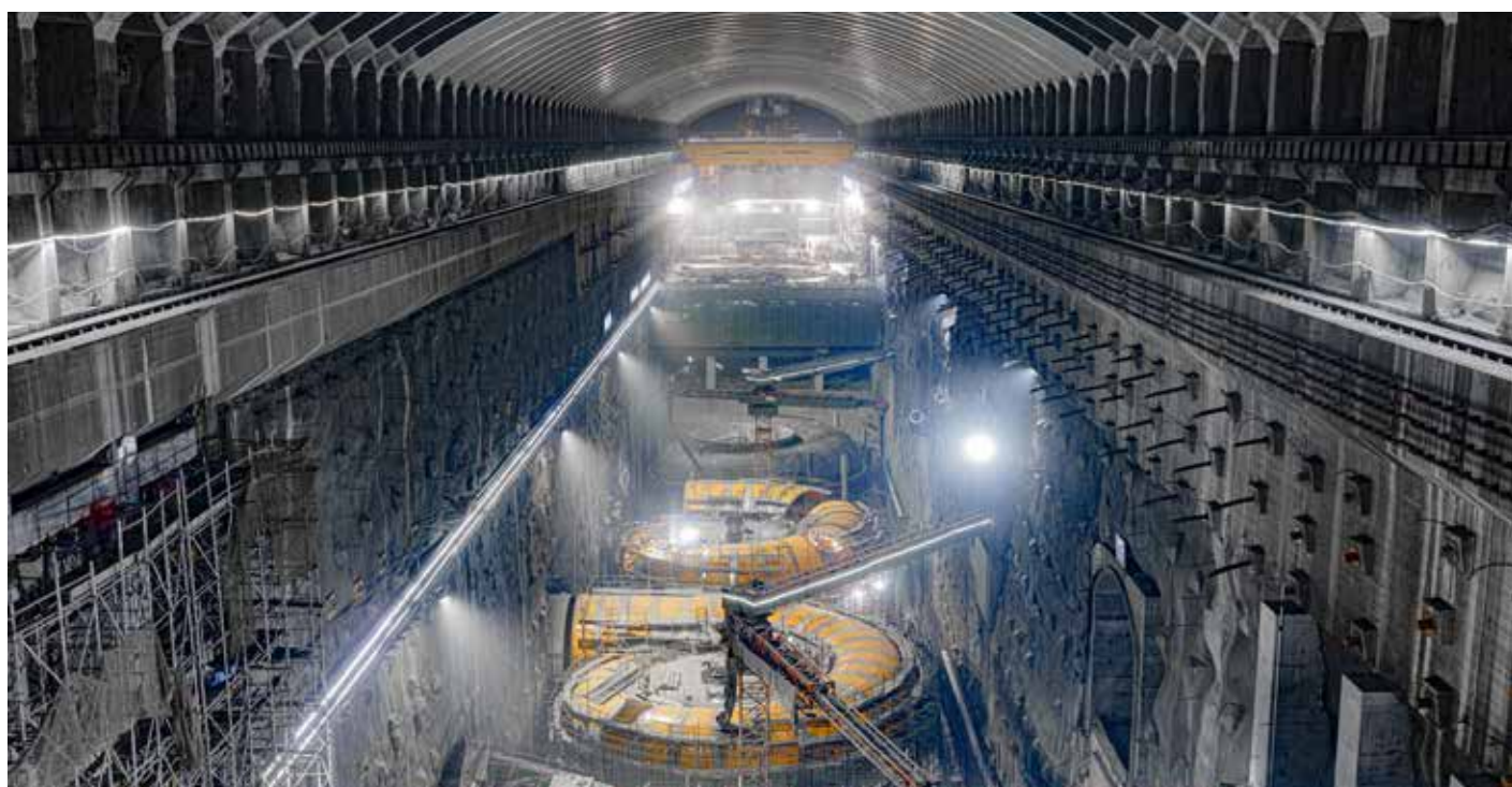
2019 年右岸地下电站主厂房
