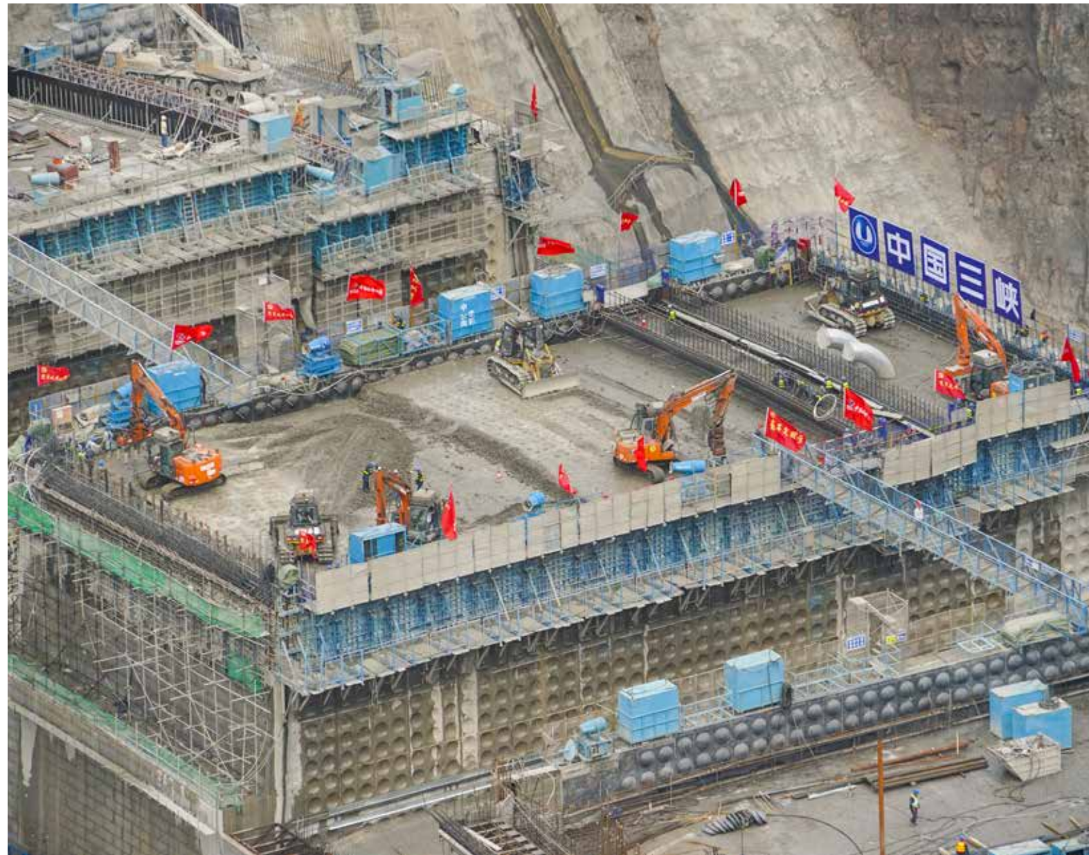
大坝 19 号坝段浇筑施工现场
