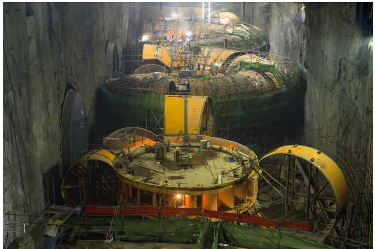
左岸蜗壳挂装现场
