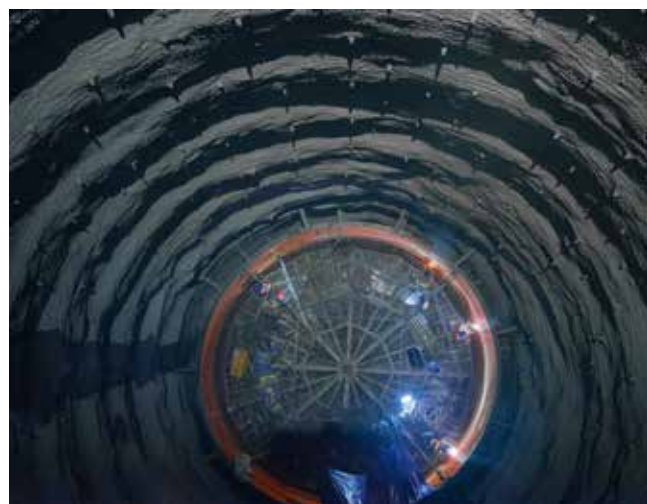
压力钢管竖井段焊接施工
