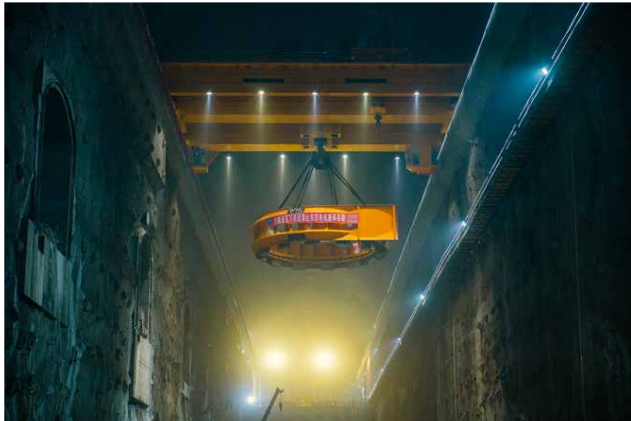
首台百万机组座环整体吊装
