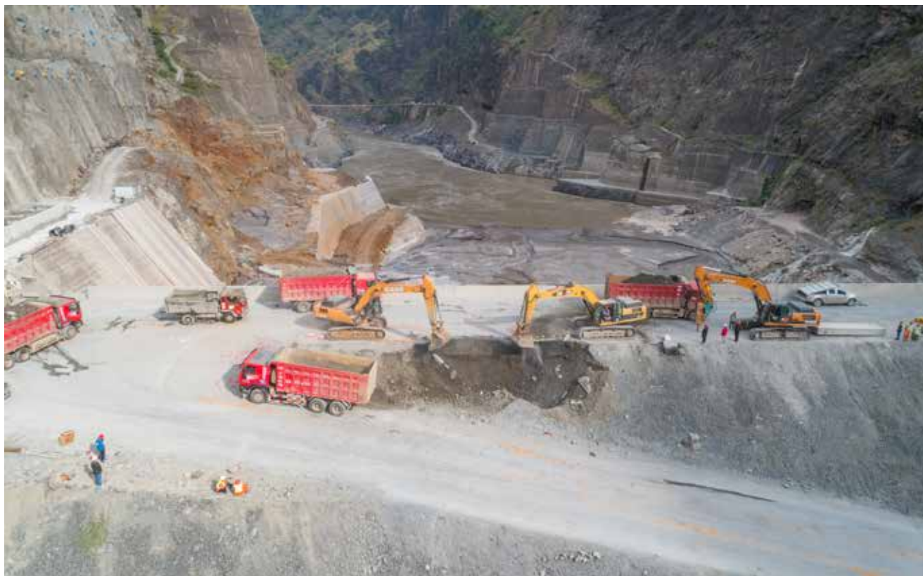
航拍下游围堰拆除开挖施工形象
