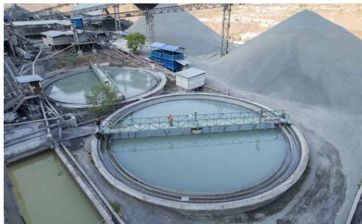
三滩砂石系统污水处理
