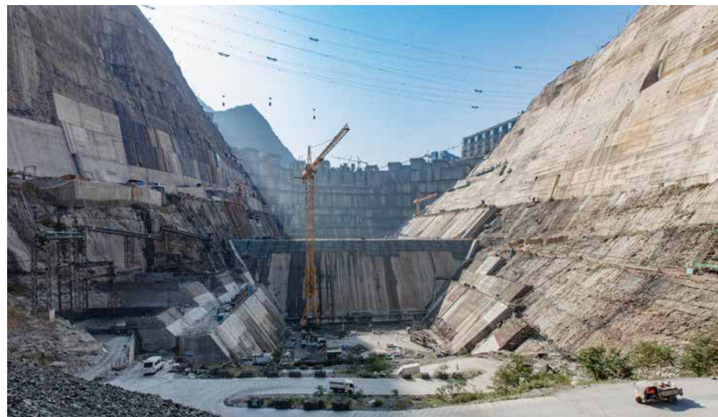
二道坝浇筑完毕形象
