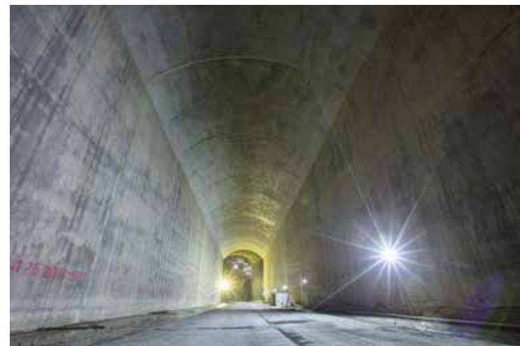
左岸1号尾水洞上中段衬砌
