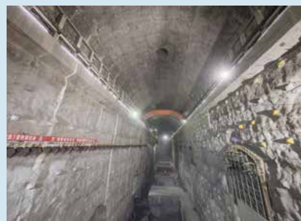
开挖完成后的地厂
