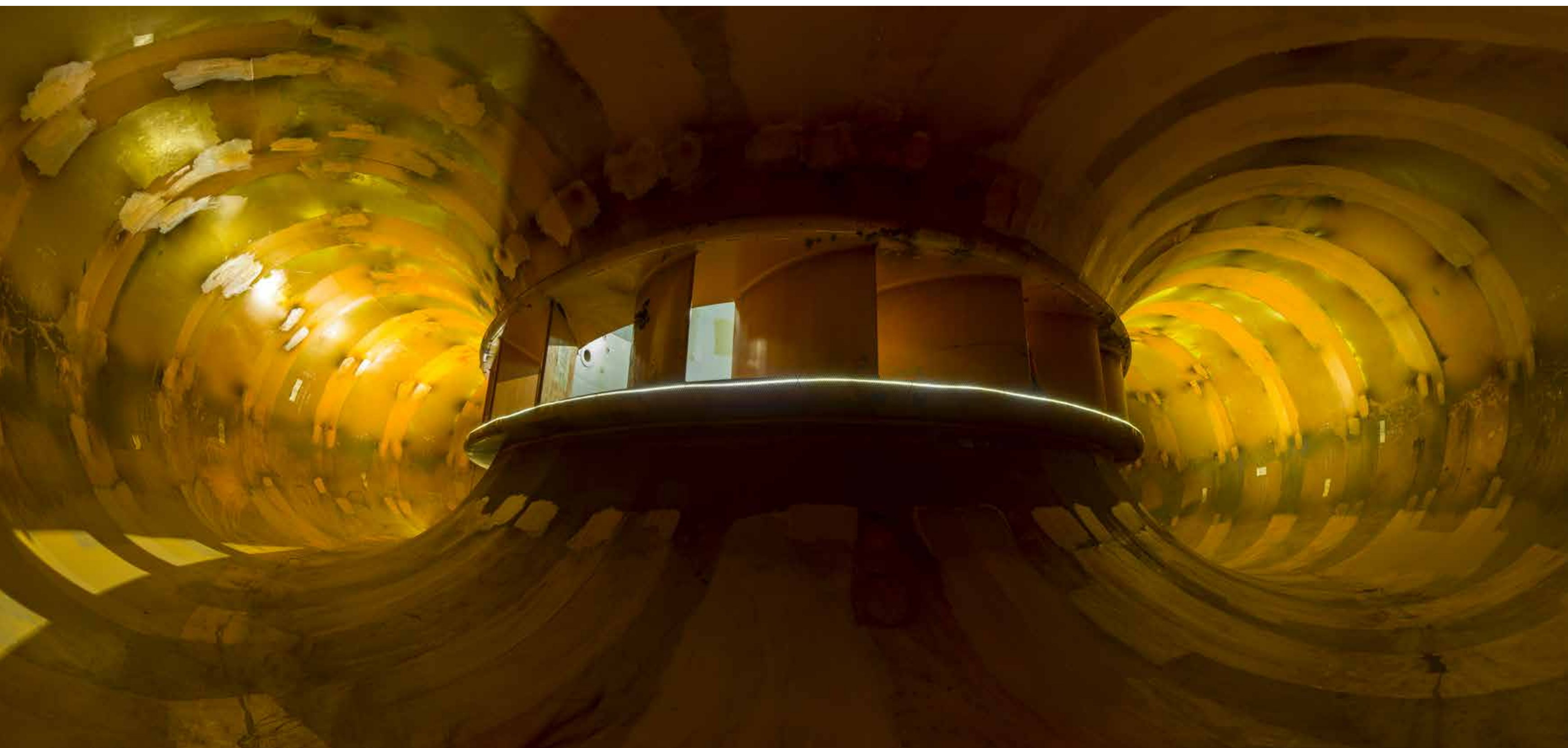
地下厂房蜗壳内部
