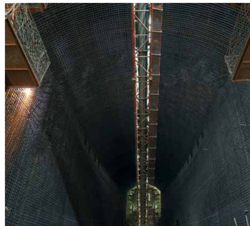
左岸 2 号泄洪洞上平段衬砌形象
