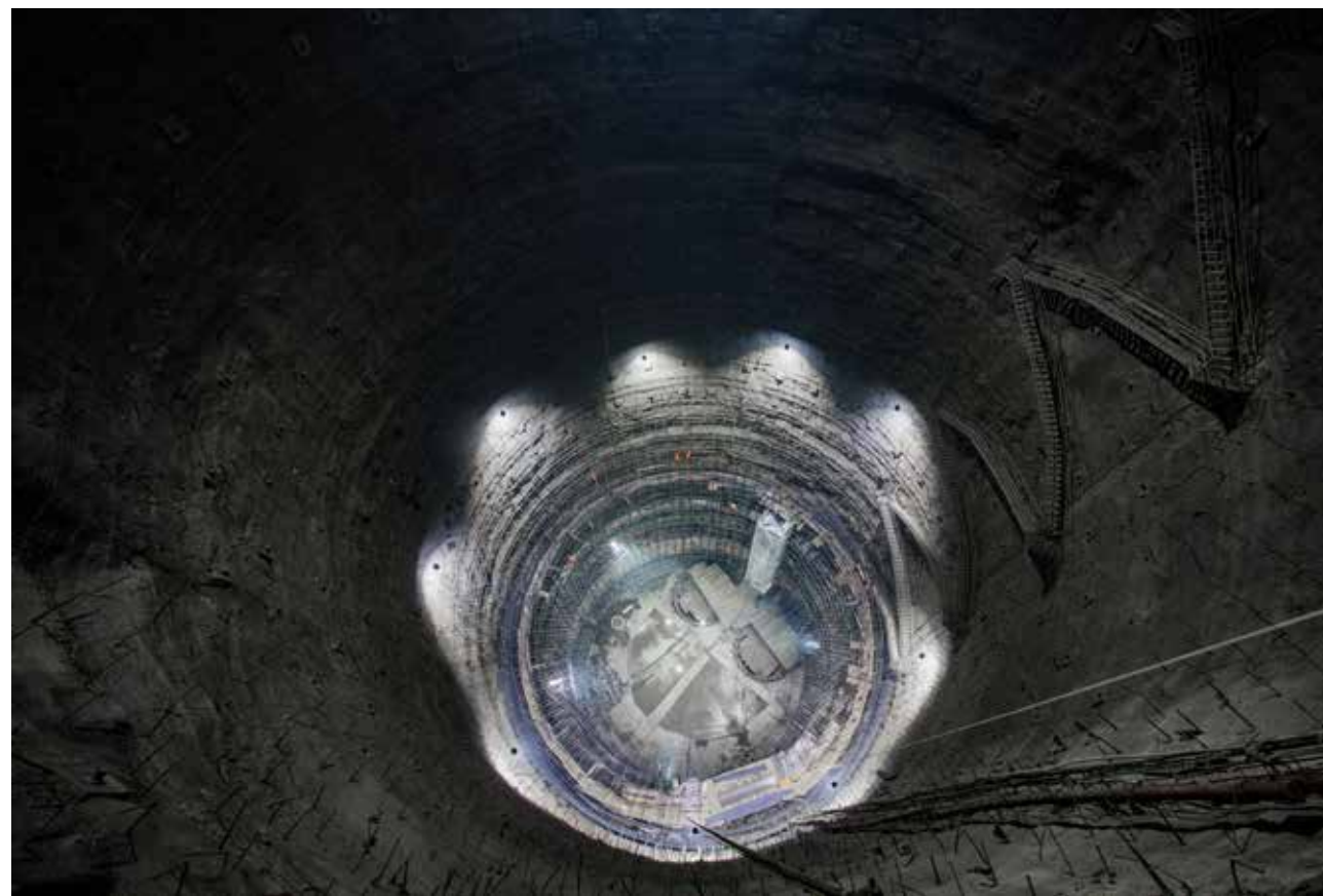
左岸 4 号尾水调压室形象
