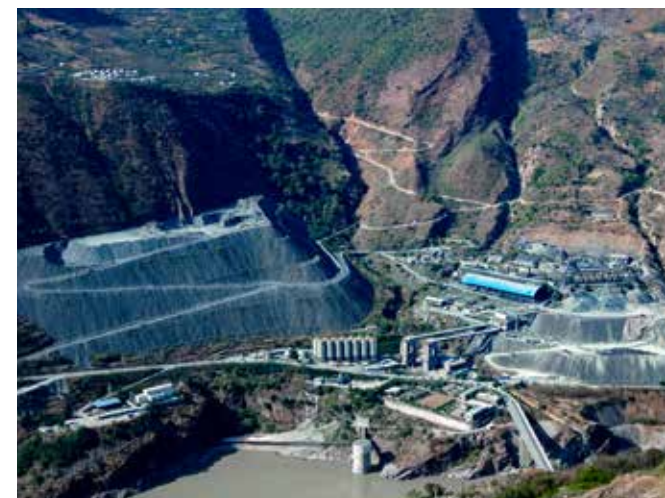
荒田大型砂石骨料加工系统厂
