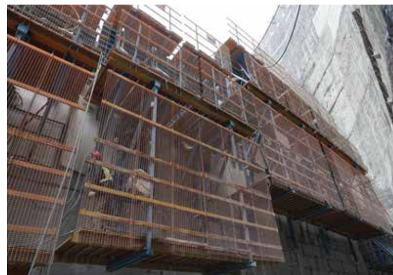
大坝 23 号坝段液压爬升模板提升施工
