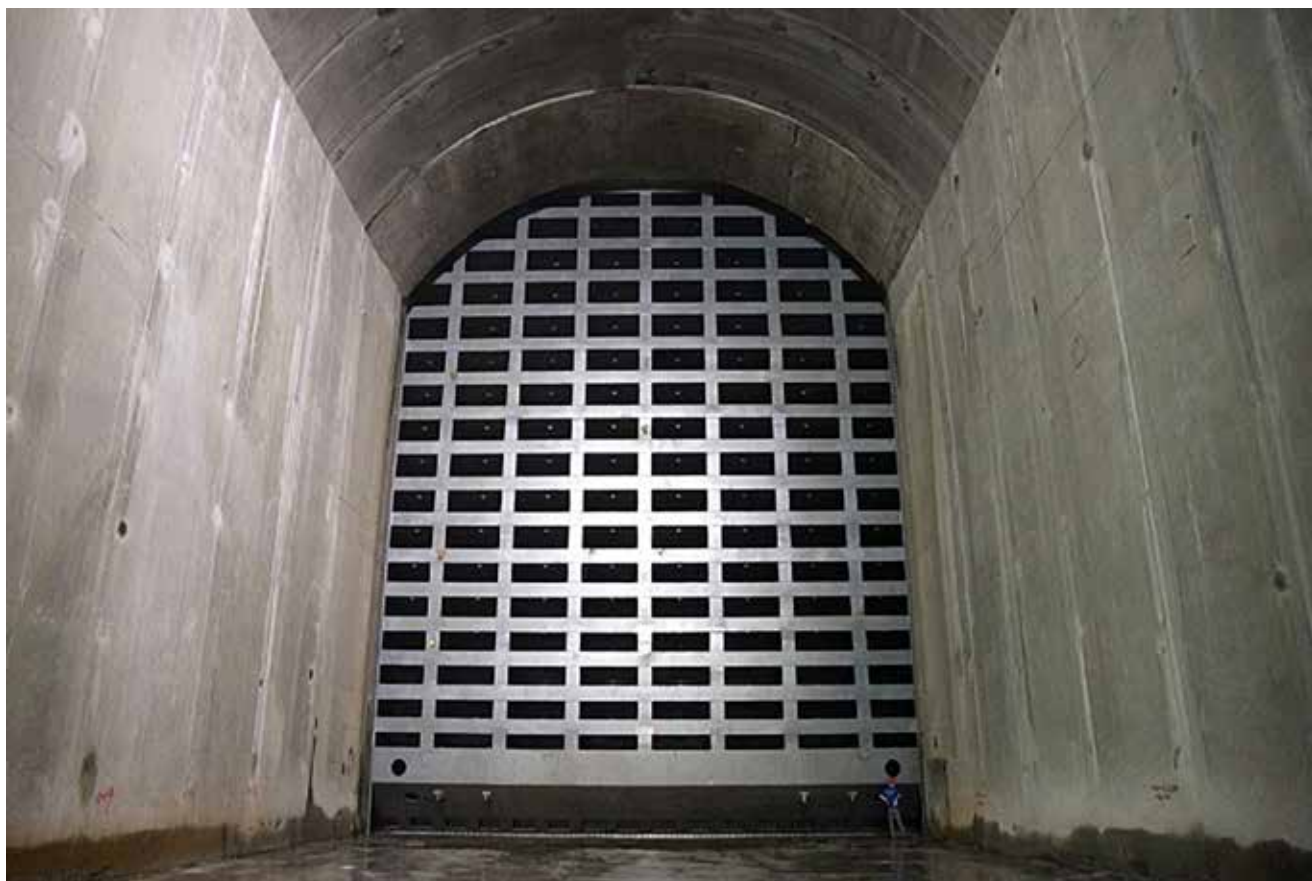
导流洞封堵闸门槽检测
