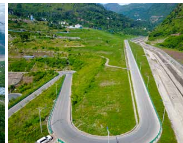
大寨沟泥石流排导槽环境综合治理
