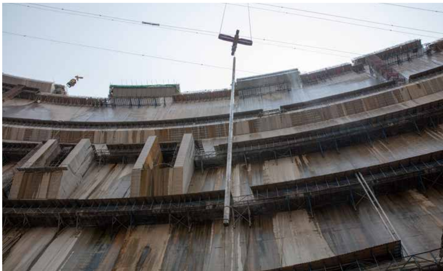
大坝混凝土浇筑取芯验收
