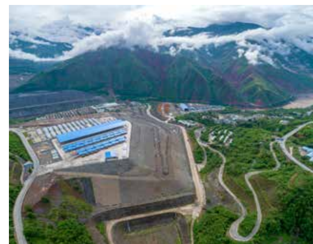
矮子沟渣厂边坡治理
