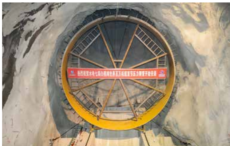
白鹤滩左岸水电站首节压力钢管下弯段安装
