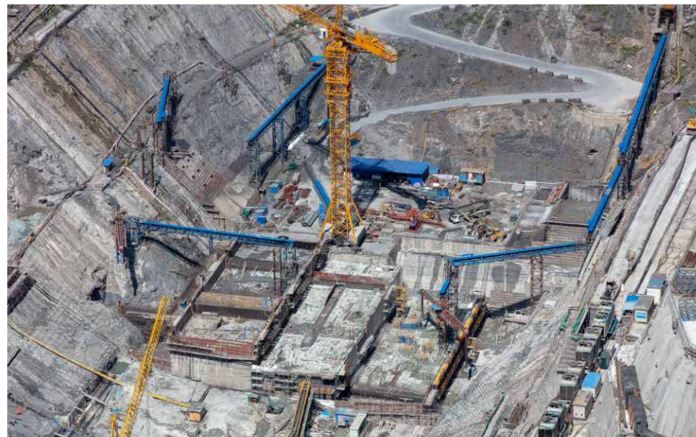
二道坝浇筑形象
