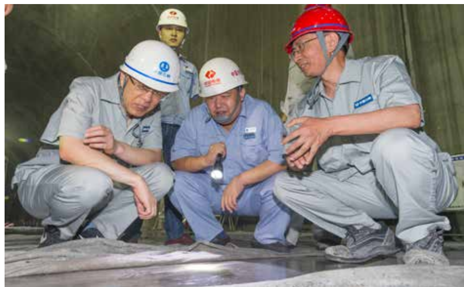
2019年5月下旬，集团公司总工程师张曙光（左一）在白鹤滩工地主持召开会议期间，现场查看泄洪洞浇筑情况。
