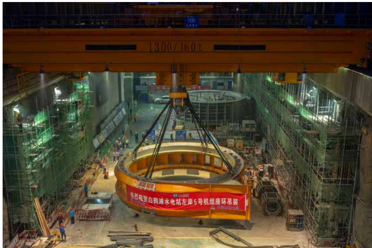
左岸最后一台座环圆满完成吊装
