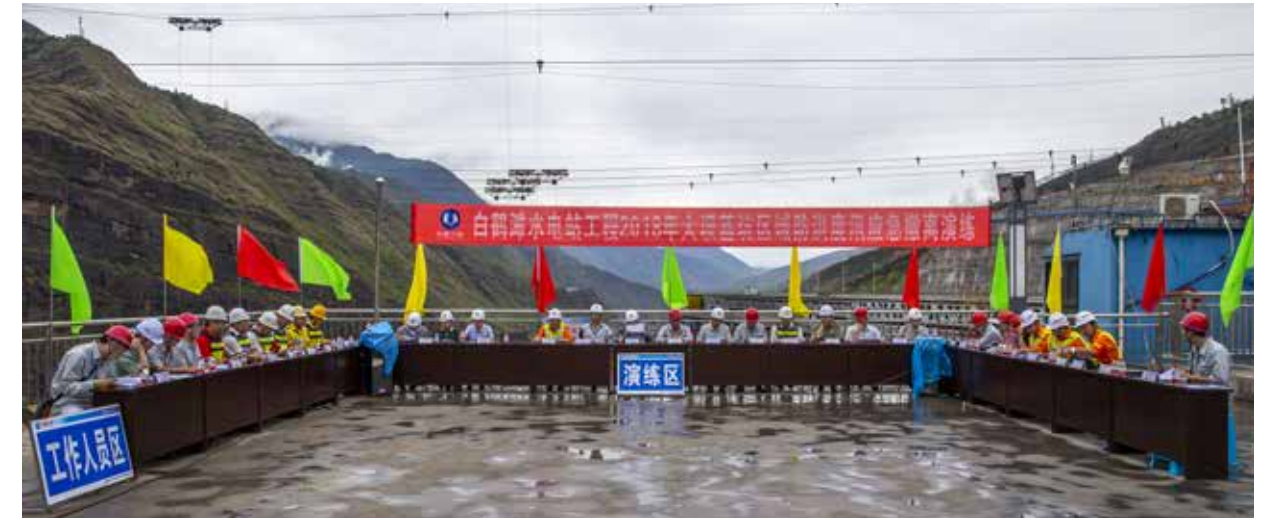
在大坝基坑区域进行防洪度汛应急演练
