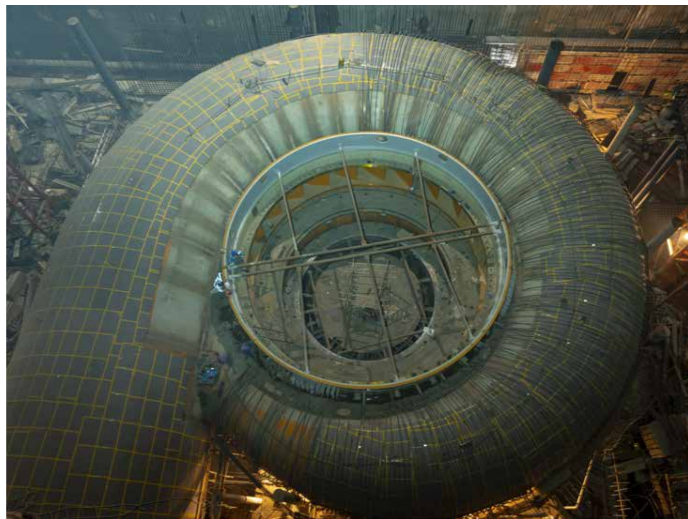
蜗壳安装与混凝土备仓
