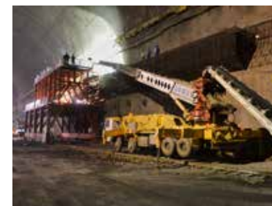
研发应用压力钢管万向运输对装台车
