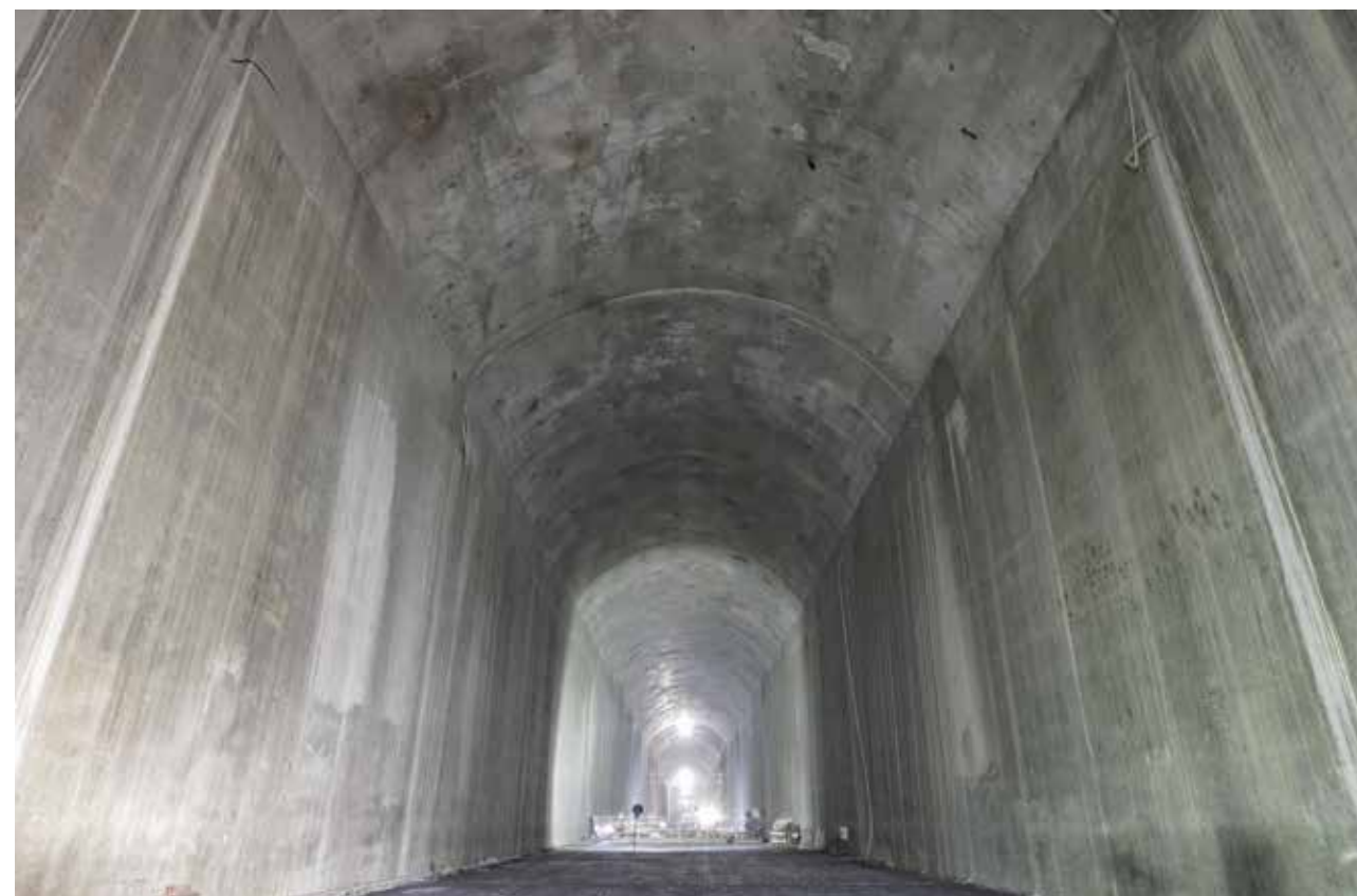
2019 年左岸 3 号泄洪洞上平段边顶拱底板衬砌形象
