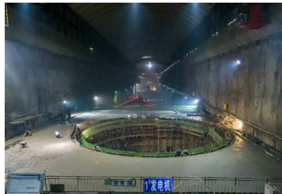
左岸地下厂房1号发电机层浇筑完成
