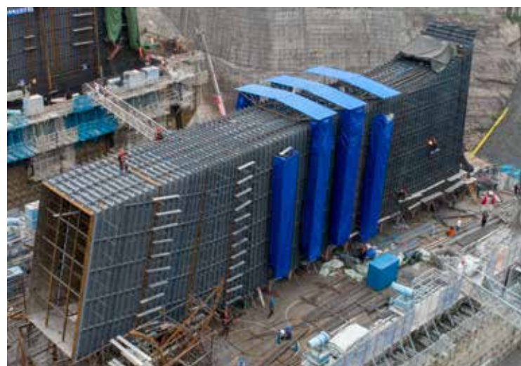
大坝导流深孔钢衬备仓安装施工形象
