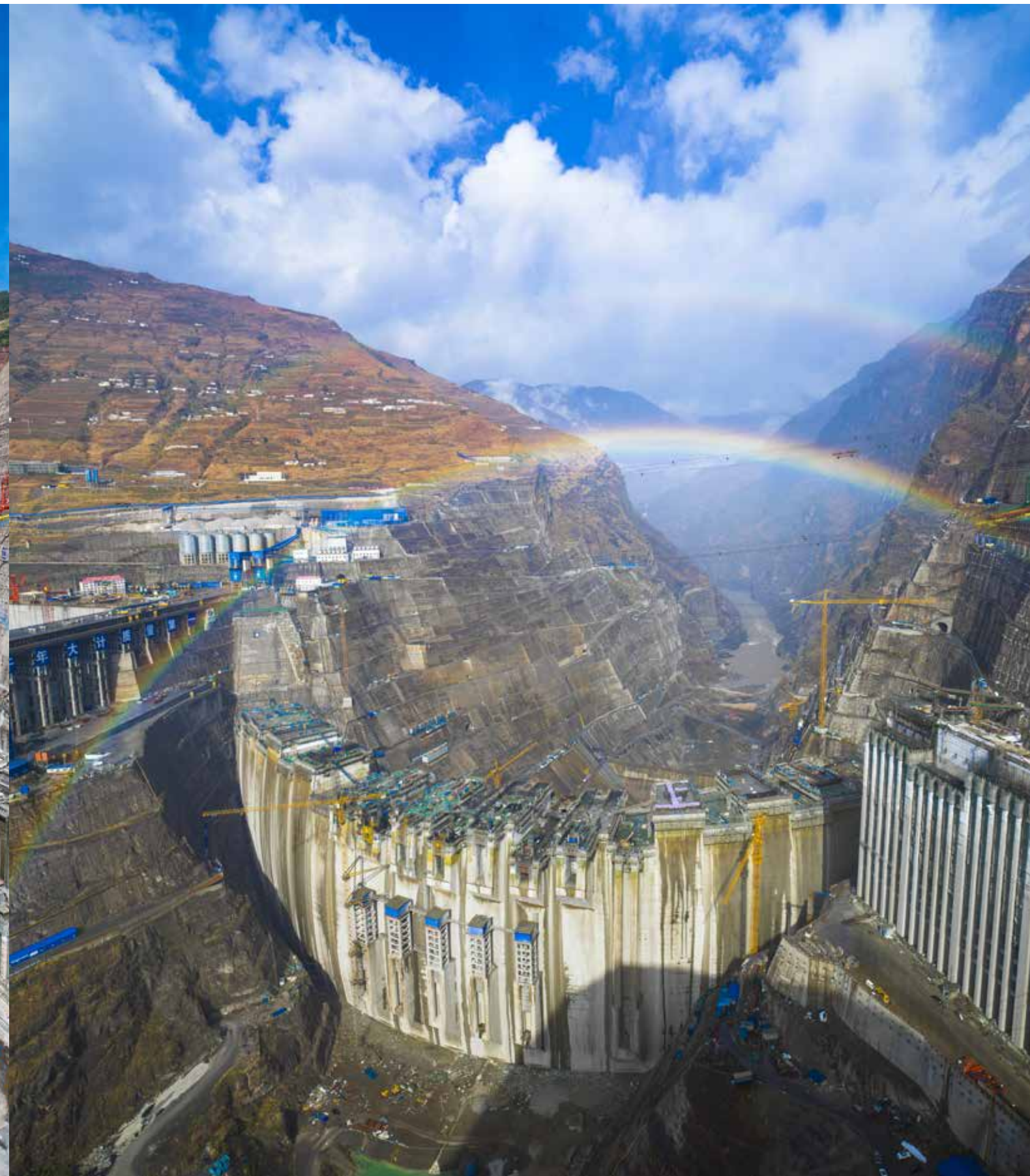
2019年白鹤滩水电站大坝浇筑形象
