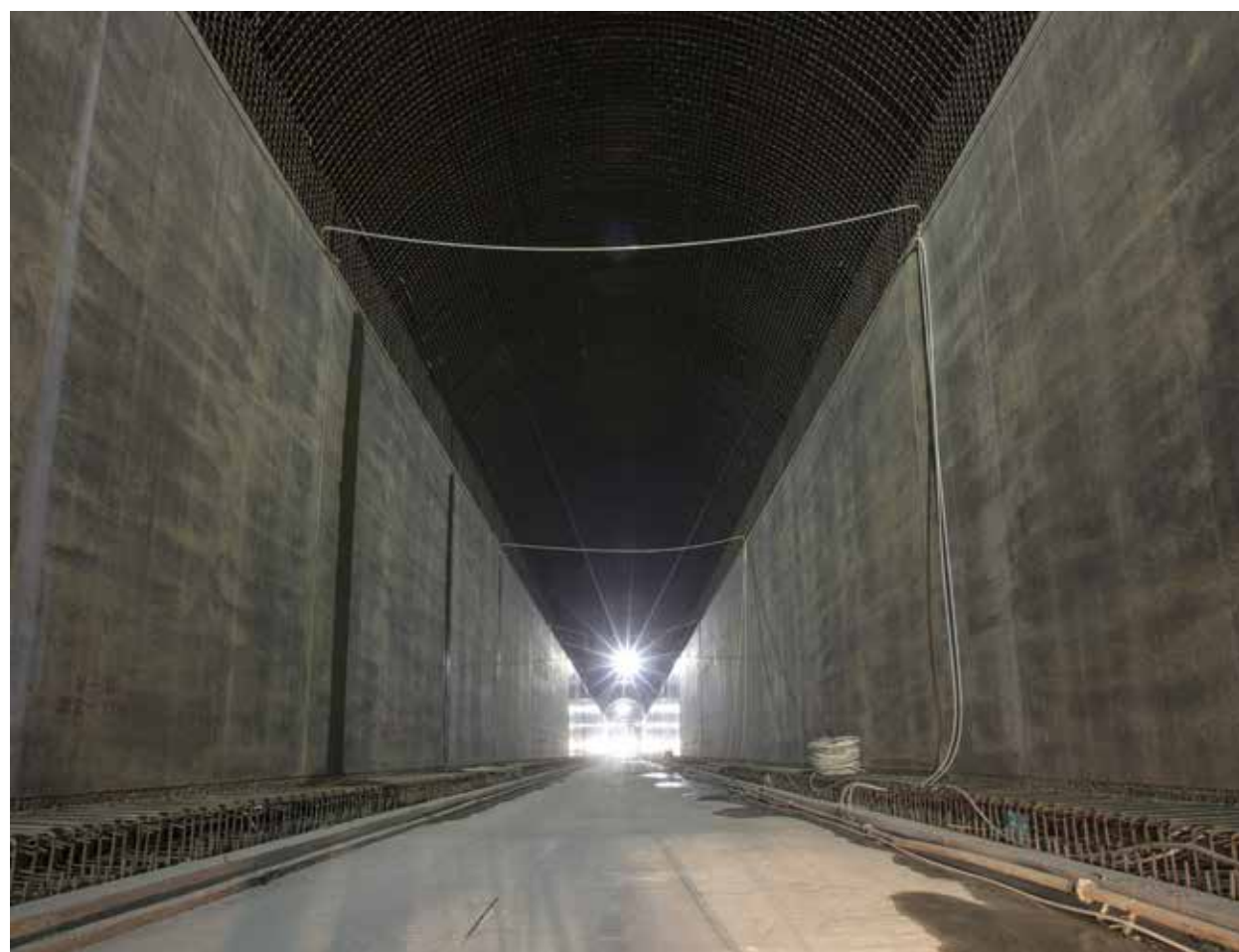
2018 年左岸 2 号泄洪洞上平段衬砌形象
