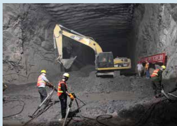
地厂开挖现场
