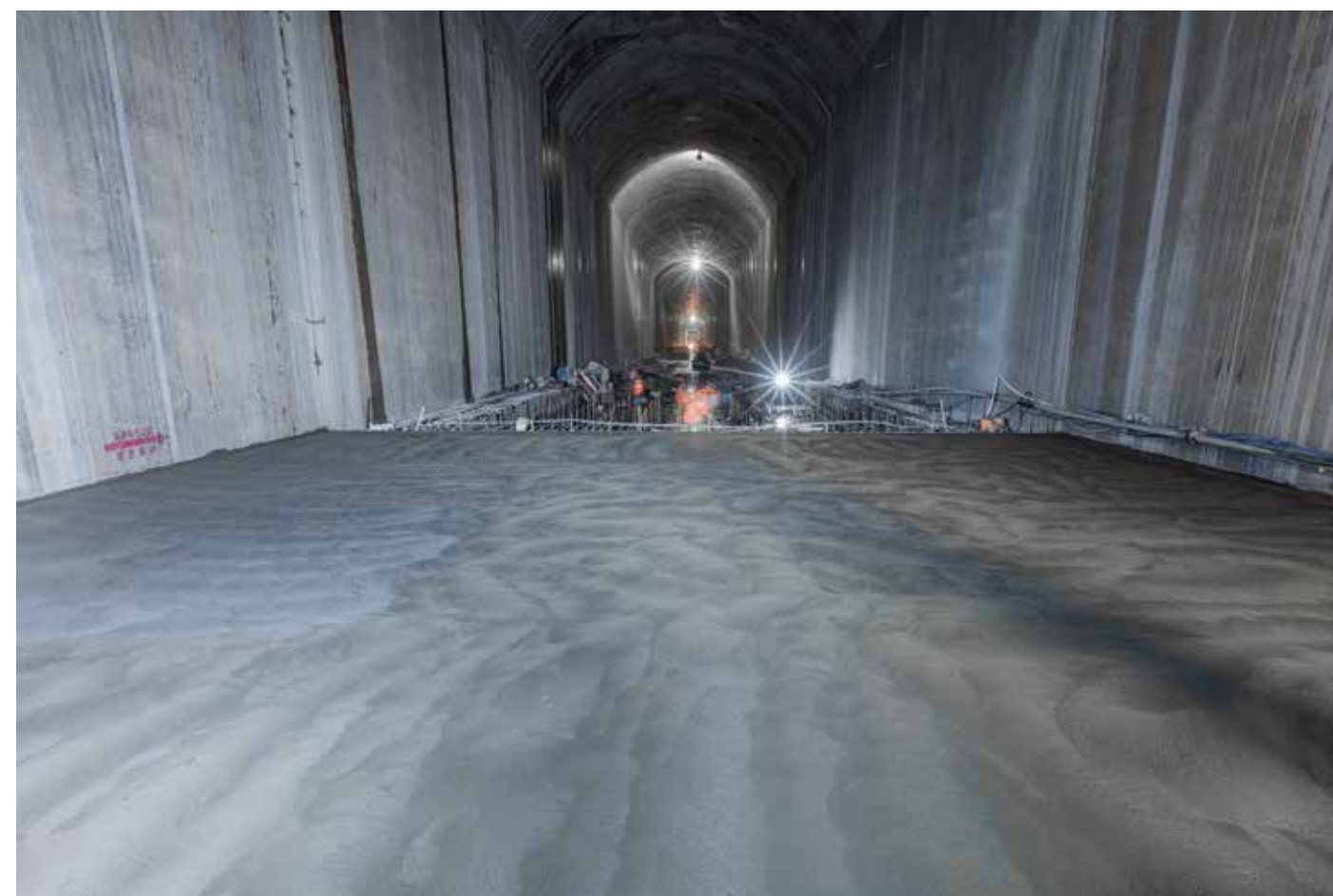
泄洪洞底板工艺
