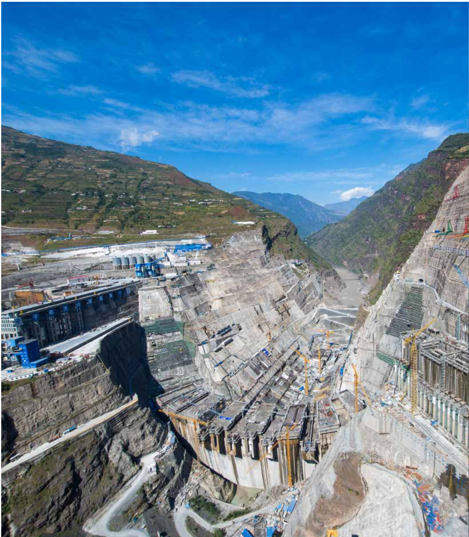
2018年白鹤滩水电站大坝浇筑形象
