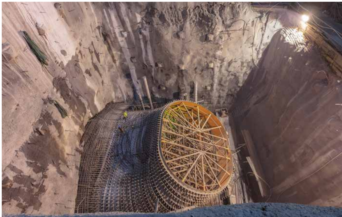
肘管安装与混凝土备仓
