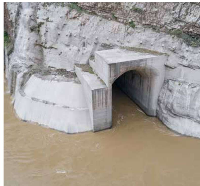
导流洞进水口形象
