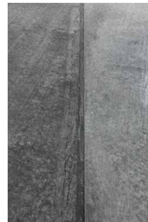
泄洪洞边墙无缝连接
