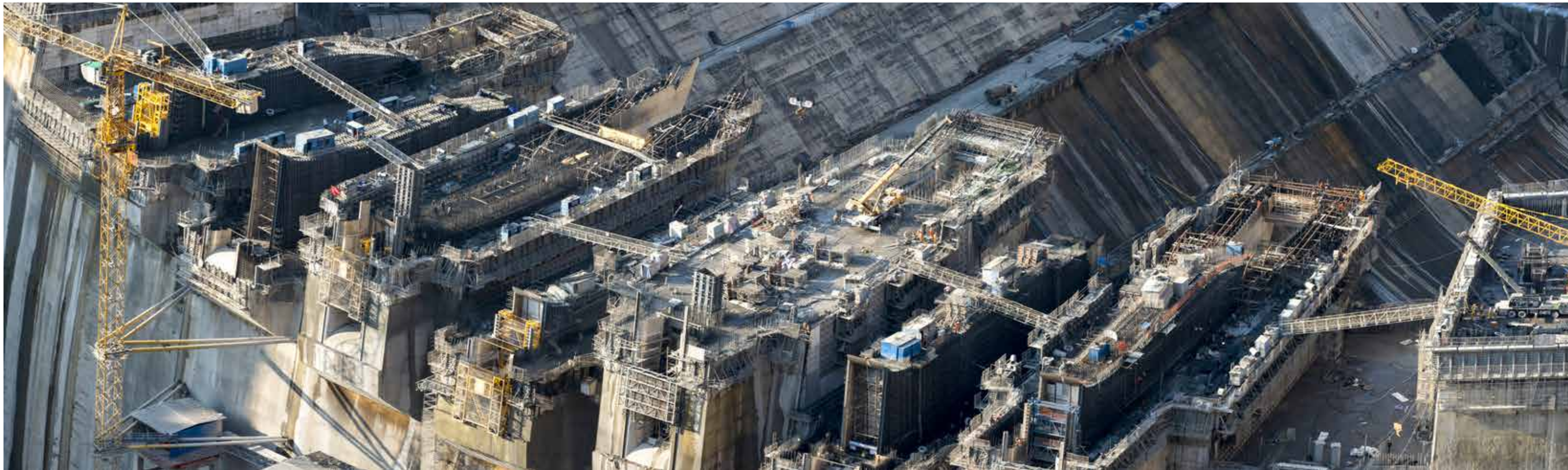
大坝深孔备仓浇筑施工形象
