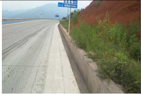
路面区现场巡查监测点
