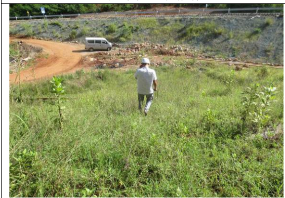
2#临时表土堆存场
