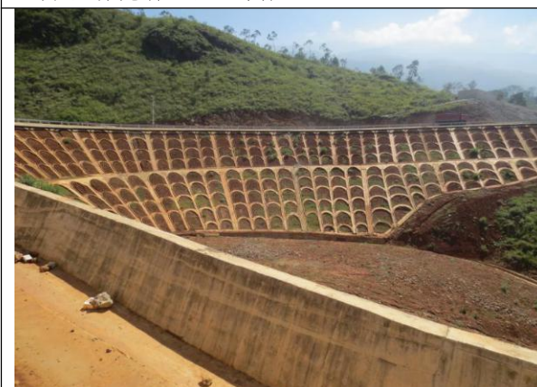
3#弃渣场现场巡查监测点
