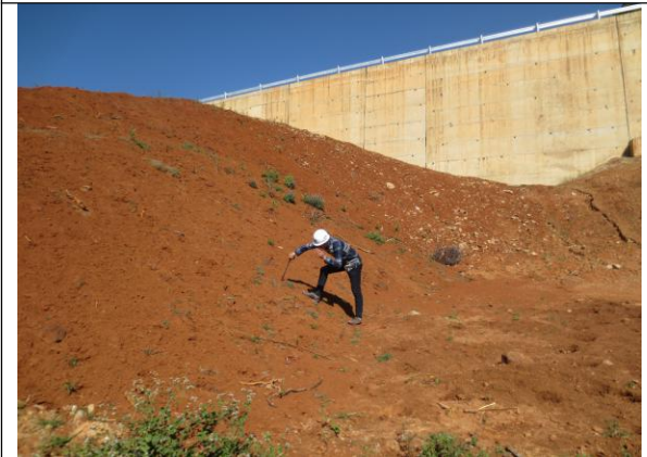
3#临时表土堆存场简易观测场
