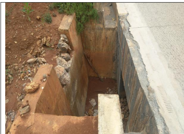
桥梁工程区沉砂池监测
