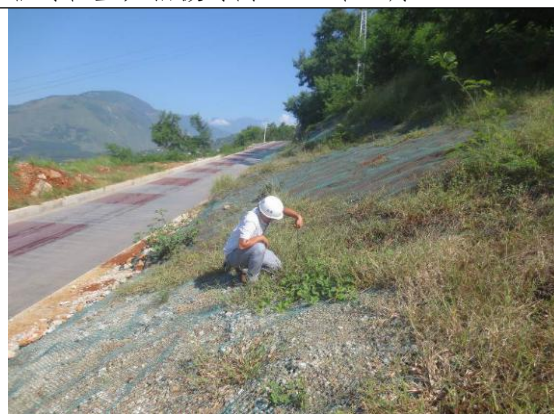
密目网临时苫盖，拍摄时间 2018 年 5 月
