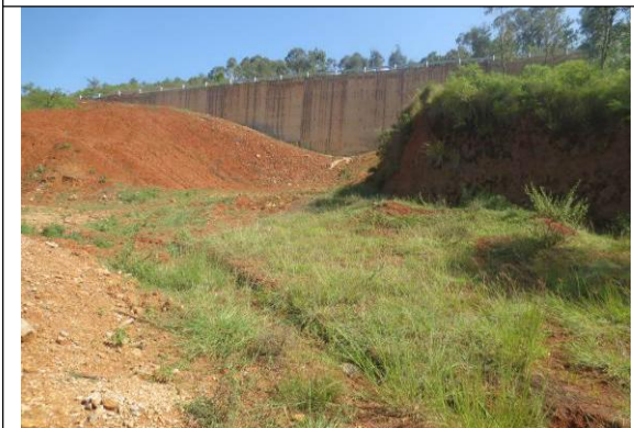
3#临时表土堆存场
