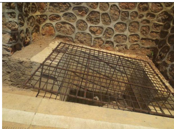
桥梁工程区沉砂池监测
