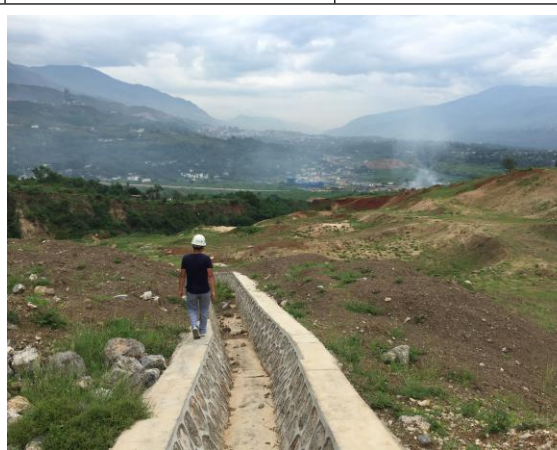
路基工程区排水沟
