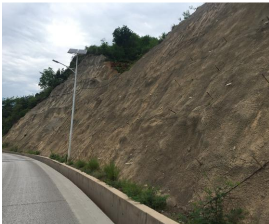
排水沟（边坡进行锚喷防护）
