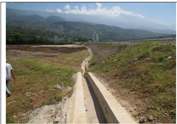
1#临时表土堆存场
