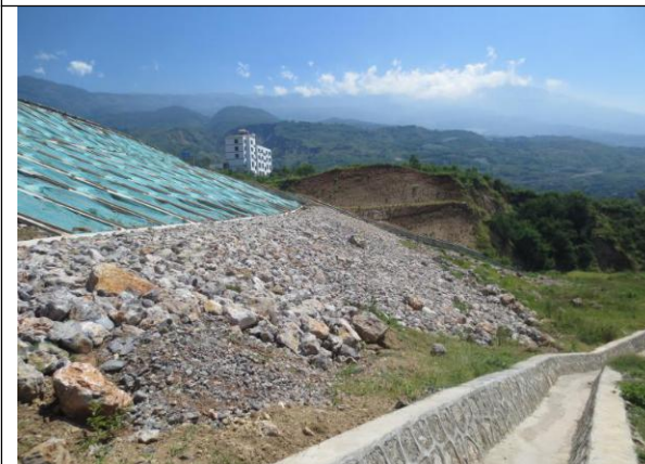
1#弃渣场现场巡查监测点
