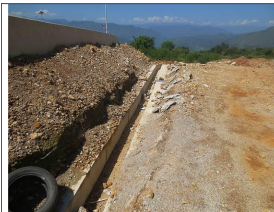
2#弃渣场边坡排水沟
