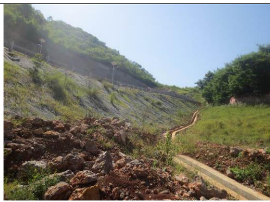
2#临时表土堆存场排水沟
