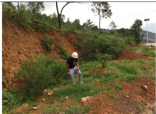
3#临时表土堆存场
