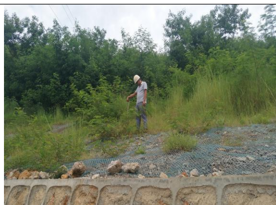
临时苫盖，拍摄时间 2018 年 7 月
