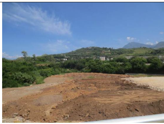
1#临时表土堆存场
