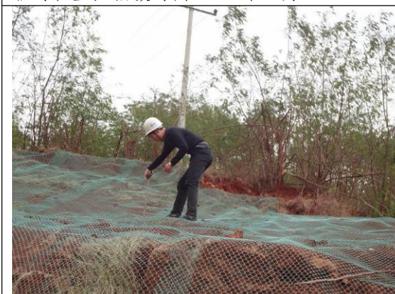
密目网临时苫盖，拍摄时间 2017 年 6 月
