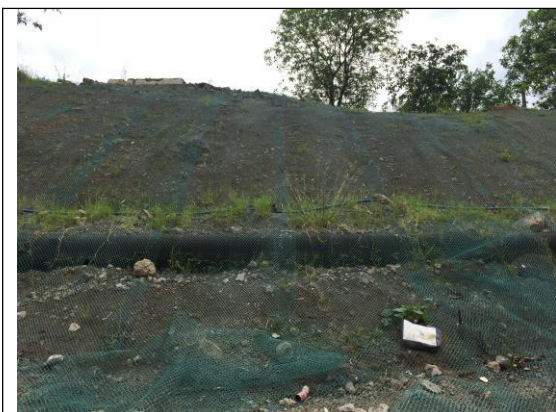
临时苫盖，拍摄时间 2018 年 7 月
