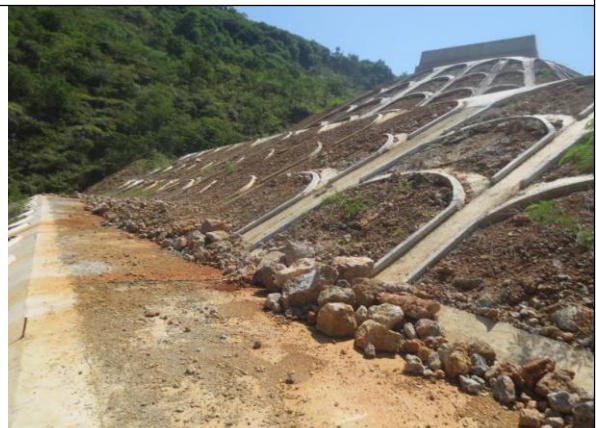
2#弃渣场现场巡查监测点
