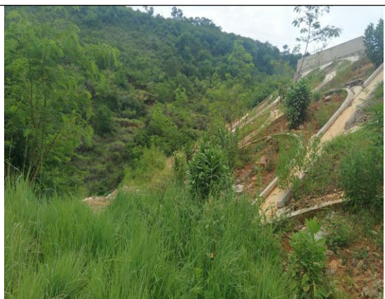
2#弃渣场坡面为框格护坡
