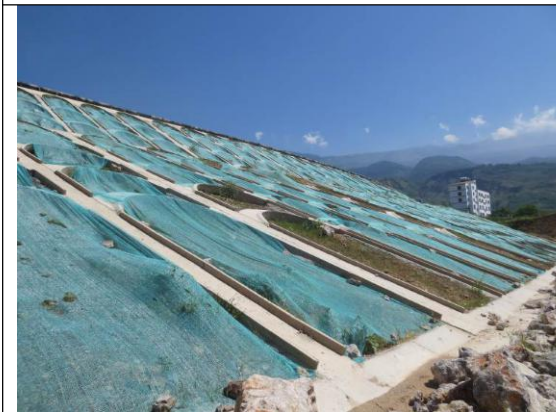
护坡临时苫盖，拍摄时间 2018 年 7 月
