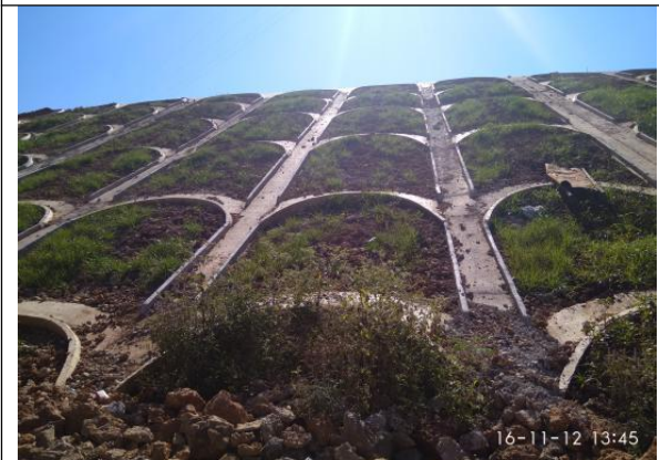
桥梁工程区植物样方点监测
