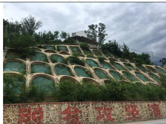
挡墙及排水沟
