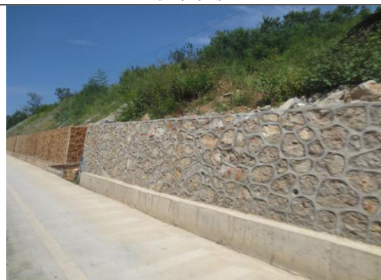
挡墙级排水沟
