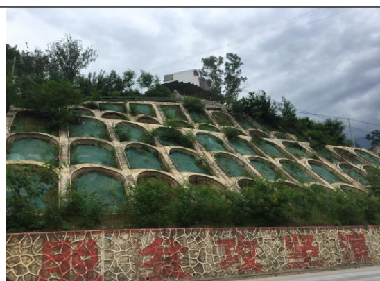
拱形骨架护坡及挡墙
