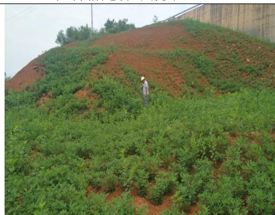
1号表土堆存场地貌恢复和植被恢复
