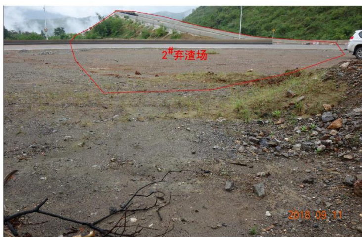
照片 3.1-1 旱谷地公路 2#渣场现状面貌（由南往北方向拍摄）
