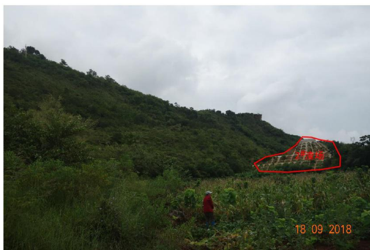
照片 3.1-2 旱谷地公路 2 # 渣场现状面貌（由北往南方向拍摄）
