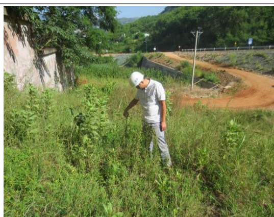
2#表土堆存场地貌恢复和植被恢复
