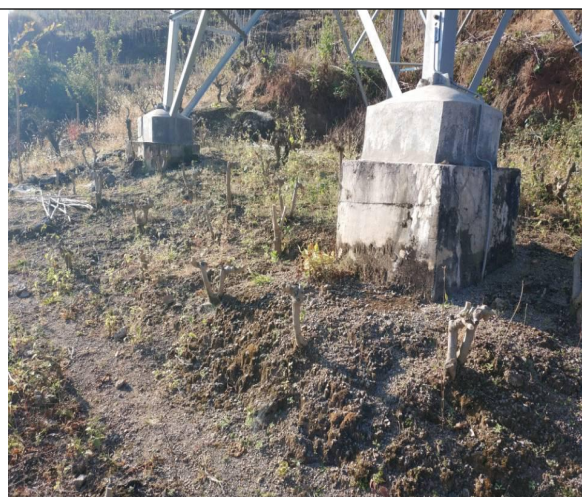
塔基挡墙硬化处理
