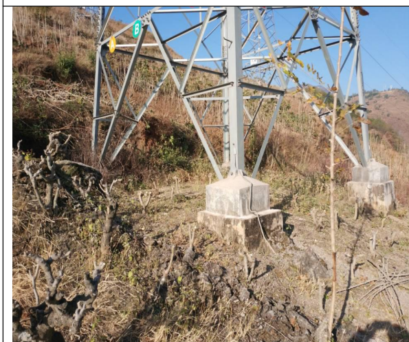
塔基硬化处理
