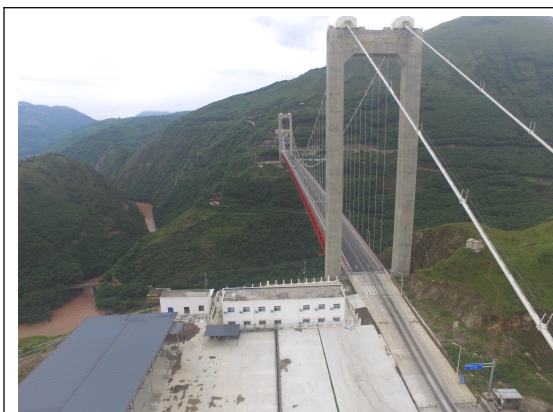
葫芦口大桥完工后无人机航拍影像
