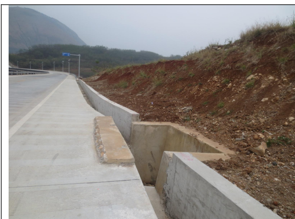
主线工程防治区 1 号沉砂池
