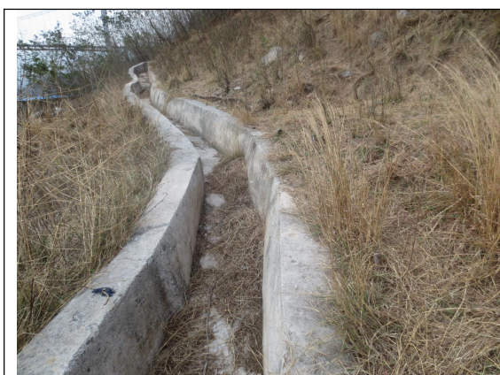
弃渣场截、排水沟
