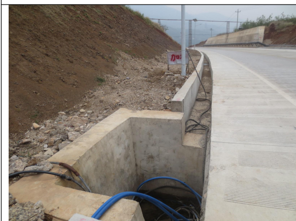
主线工程防治区 3 号沉砂池
