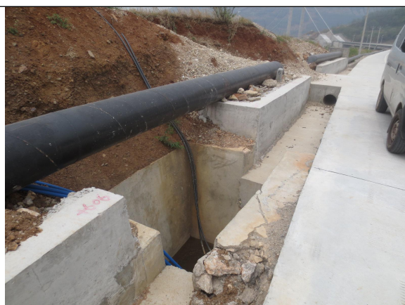
主线工程防治区 2 号沉砂池
