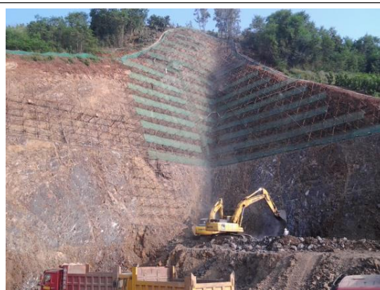
施工中边坡排水沟、绿网防护
