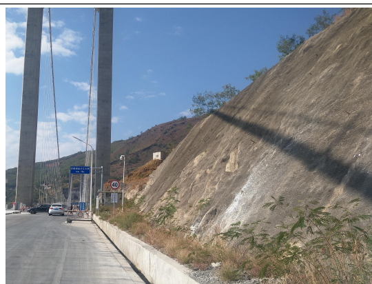
排水沟（边坡进行锚喷防护）
