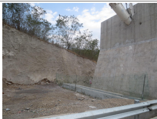
排水沟、边坡锚喷防护
