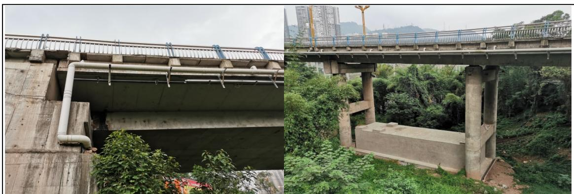
图 10-1 桥面径流收集系统及事故应急池
