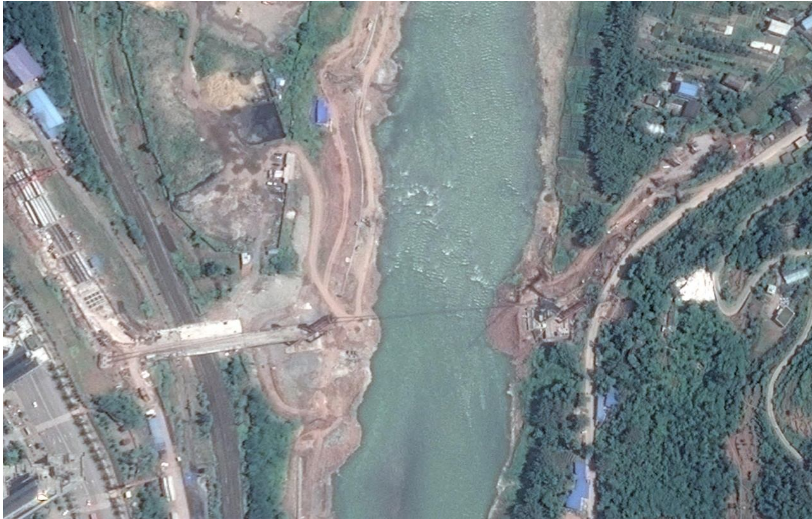
横江大桥工程影像图-施工阶段（2016年5月）
